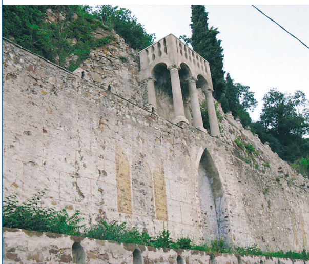
In alto l'incompiuto Castello dei Ciucioi, e, qui sopra, gli attuali lavori di sistemazione
